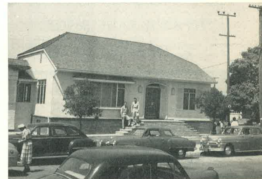
Neues Pfarrhaus. — New Parish House. — Az új plébánia.
